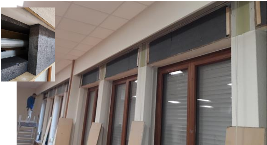
(Bild 6 massive Dämmung der Rollladenkästen)
